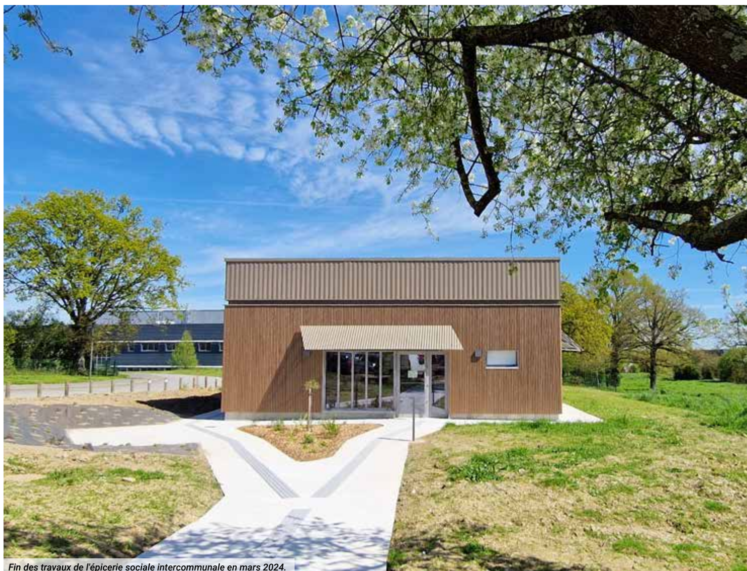
Fin des travaux de l'épicerie sociale intercommunale en mars 2024.
